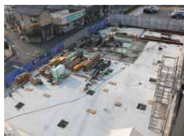
2020年2月3日(月) 基礎工事
