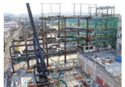
2020年2月19日(水) 鉄筋工事
